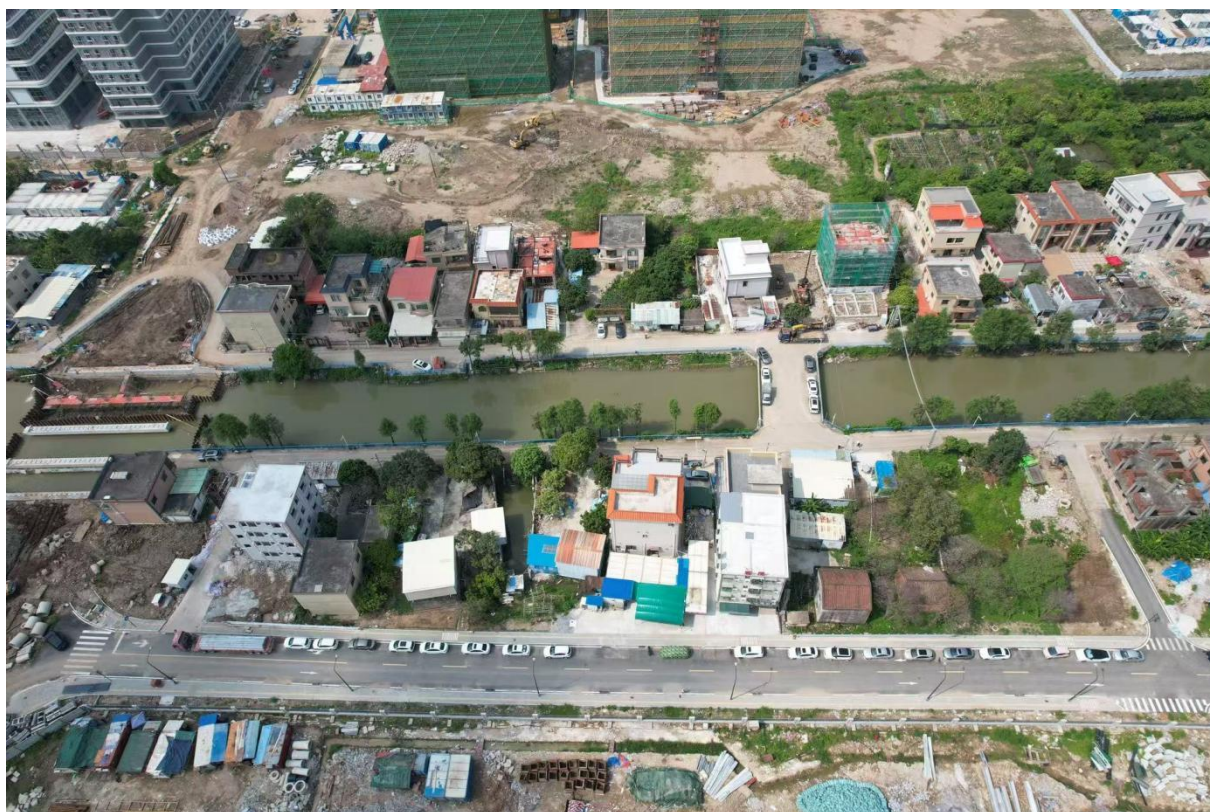
项目南侧现状（拍摄时间：2026 年 4 月）
