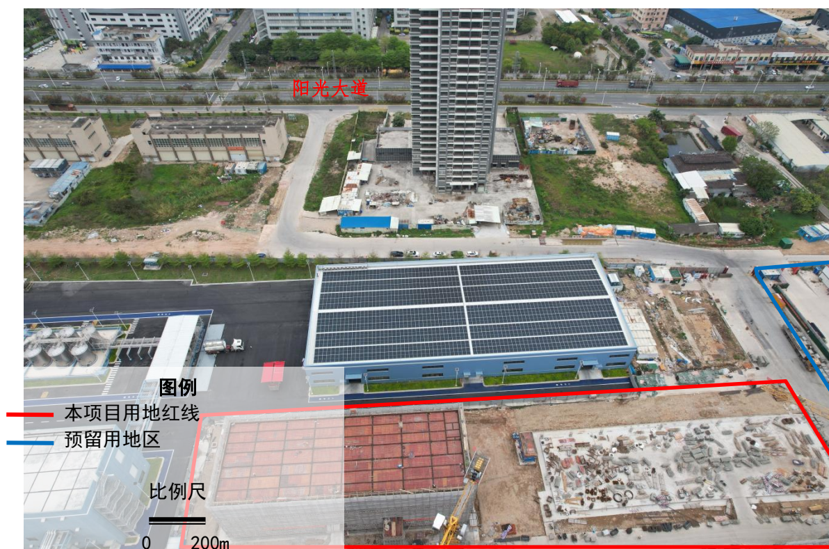
项目北侧现状（拍摄时间：2026 年 4 月）
