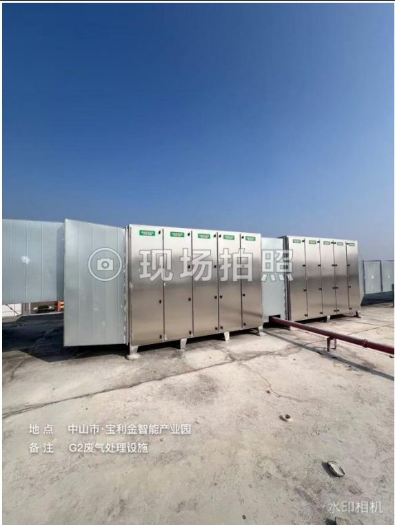
刷红胶及固化、刷锡膏、回流焊、波峰焊、擦拭、点胶、自然晾干、焊 DC 线废气 (G2) 处理设施
