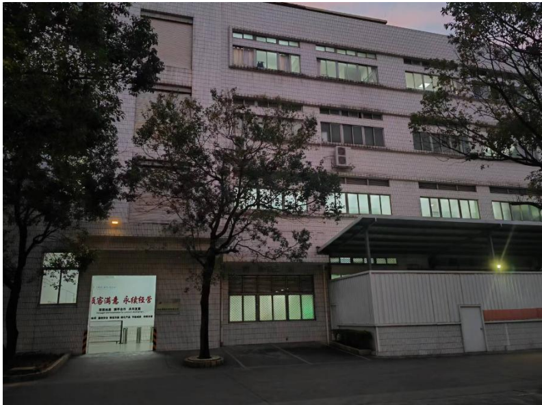
图 4 项目厂区现场图片
