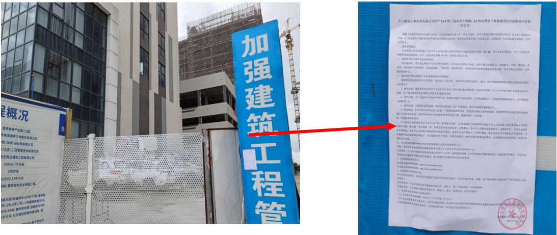
(1) 项目厂区出入口
