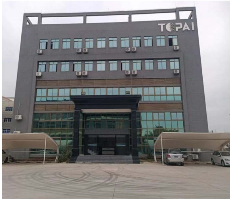
图 2 项目厂区现场图片
