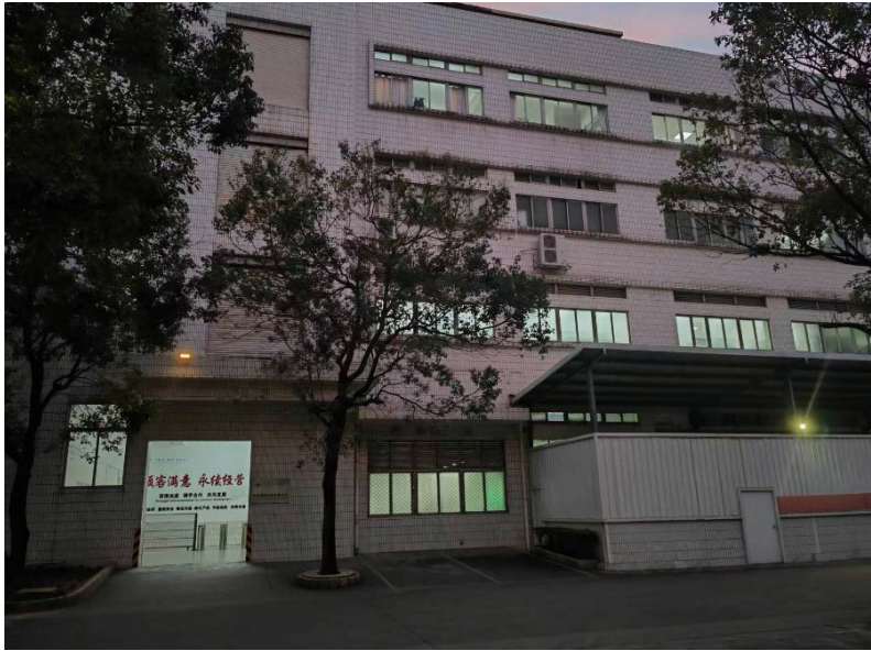
图 4 项目厂区现场图片
