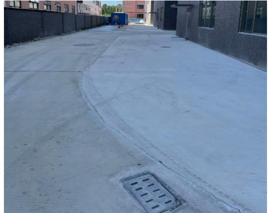
排水沟及雨水管道
