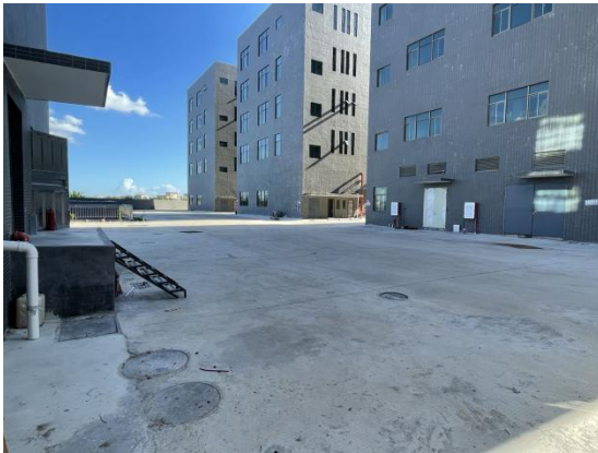
园区内雨水口
