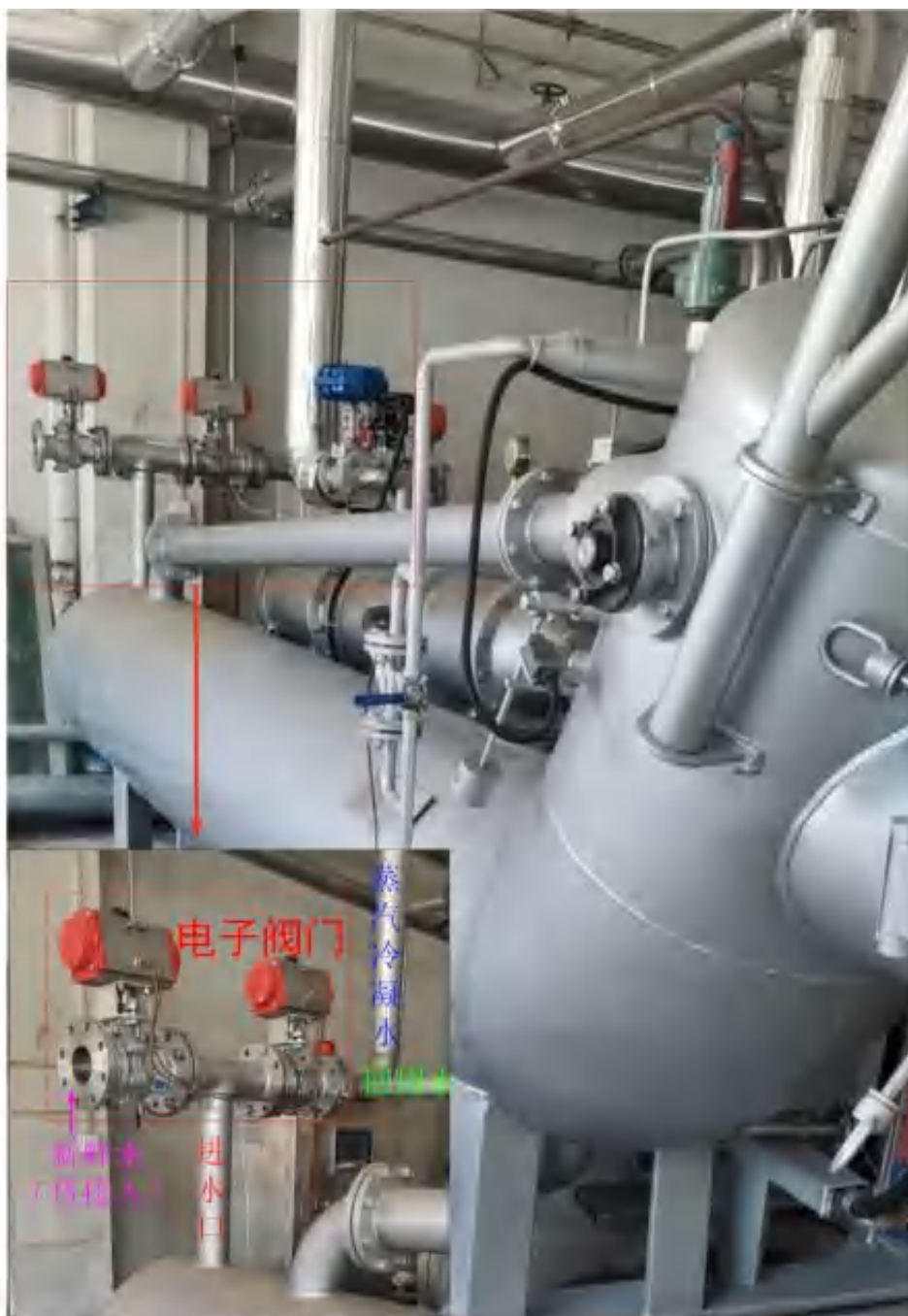
图 7.3-4 染色机进水口示意图
