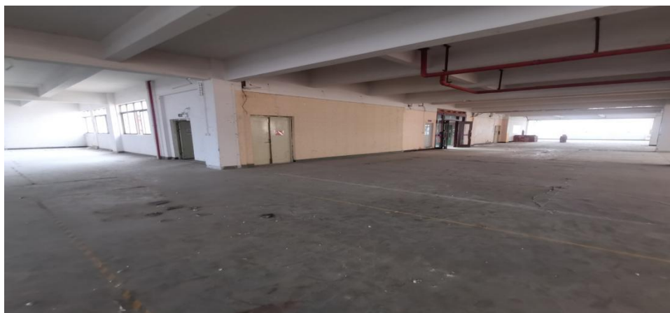
图 3 项目车间现场图片
