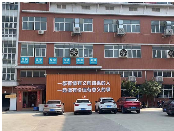
图 5 项目厂区现场图片
