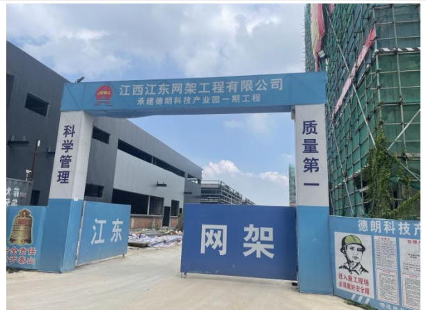
项目北侧为在建厂房
