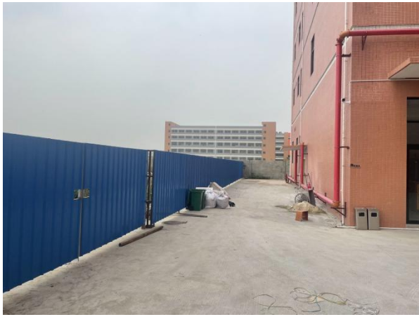
施工现状（左侧为三期地块，右侧为厂房一）
