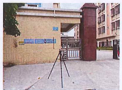
图 6.6 厂界东北面 1m 外监测点 N1
